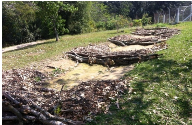
Figura 21. Canteiros em curva de nível para contenção de processo erosivo.
