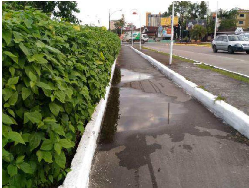
Figura 24 – Problema de drenagem na margem oeste do Rio Cachoeira.
