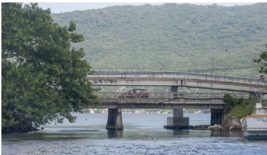
Figura 12: Ponte, antiga e nova, da Barra da Lagoa
