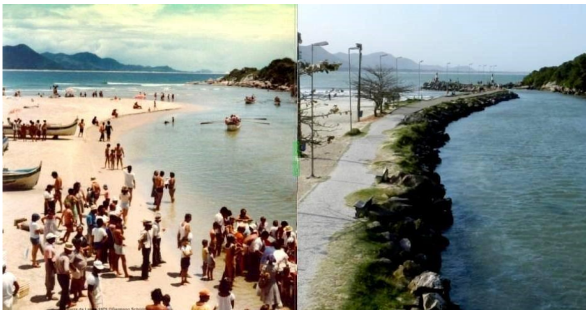
Figura 11: Foto de antes e o depois da construção dos molhes Canal da Barra da Lagoa
