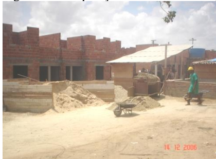
Figura 13 - Disposição das baias em relação à betoneira.
