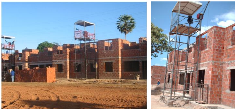
Figura 25 - Tipo de transporte vertical escolhido para obra.
