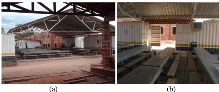
Figura 22 - Área de vivência da obra.
