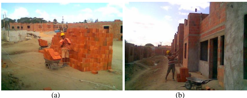
Figura 14 - Tipos de transporte existentes na obra.
