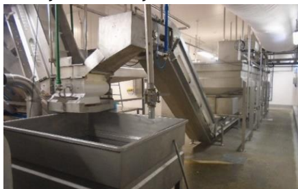
Figura 29: Instalação e reposicionamento de equipamentos – Tumbler e balança muticabeçal.
