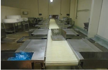
Figura 28: Sistema de transporte de produtos por esteiras mecanizadas.
