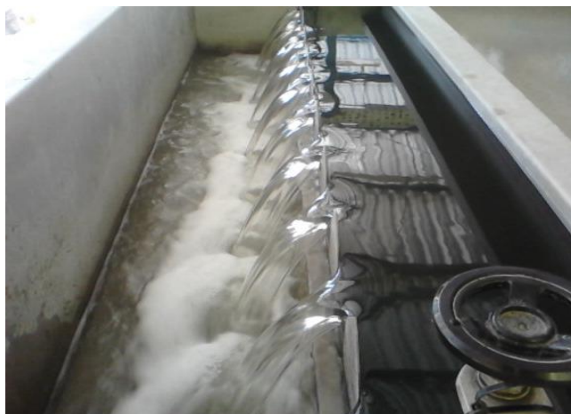
Figura 6 Efluente clarificado ao final do tratamento – ETE Bombinhas.
