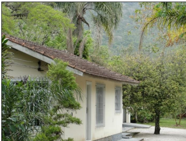
Figura 38 – Residência A, localizada dentro da APP de margem de rio da área de estudo no Ribeirão da Ilha, Florianópolis, SC.
