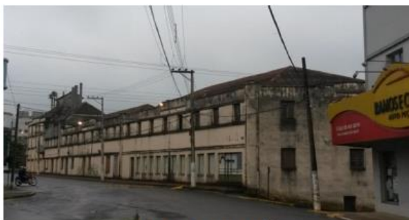
Fachada principal da edificação
