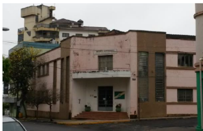
Fachada principal da edificação
