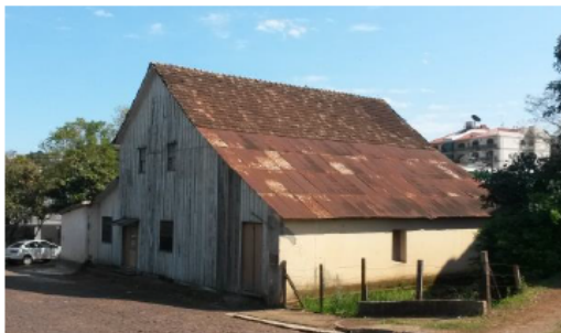
Fachada principal da edificação
