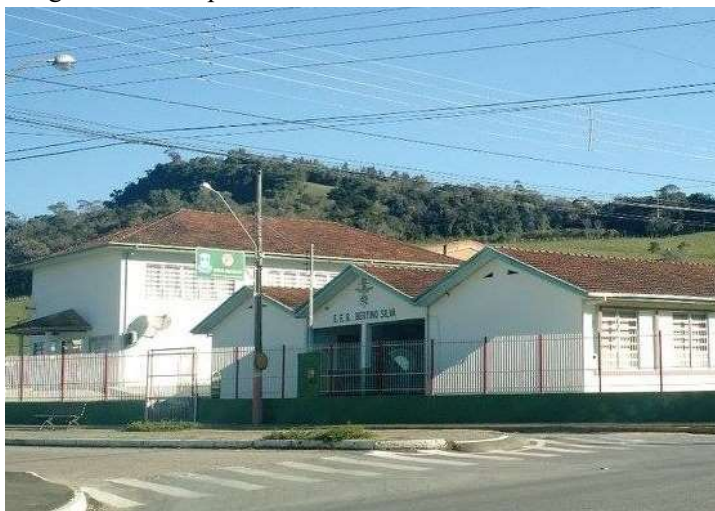
Imagem 2 - Vista parcial da EEB Bertino Silva
