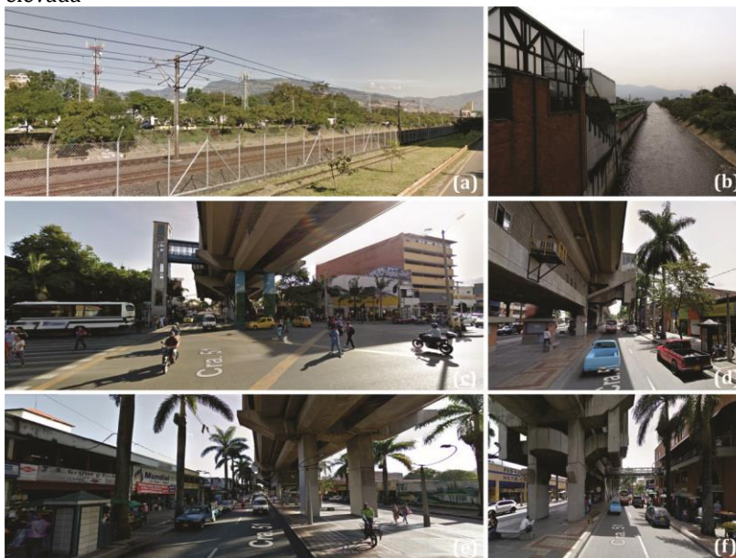
Figura 68. (a), (b) Linha férrea superficial; (c), (d), (e) e (f) Linha férrea elevada
