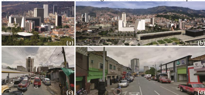
Figura 64. (a), (b) Centro Cívico e Administrativo; (c), (d) Contraste entre o Centro Cívico e Administrativo e a região Norte do vazio industrial tipo 4
