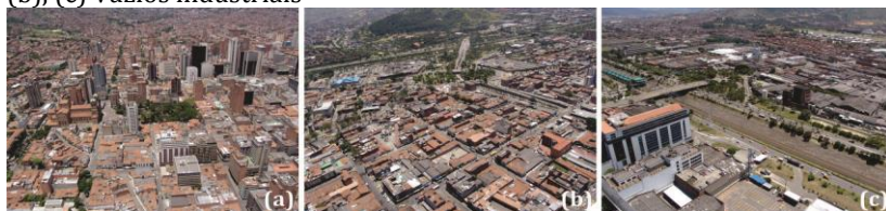
Figura 22 Parcelamento regular nas áreas de planície (a) Centro histórico; (b), (c) Vazios industriais
