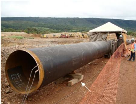
Figura 2. Posicionamento dos dutos para execução da soldagem orbital no compartimento branco, com destaque para o método de sustentação do tubo
