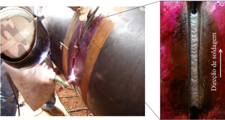
Figura 4. Vista geral do procedimento de soldagem do passe de raiz de forma manual com o processo TIG (esquerda) e aspecto superficial do passe de raiz (direita)
