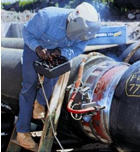
Figura 6. Mecanização da soldagem orbital de dutos de grande diâmetro com um manipulador linear controlado por *joystick*
