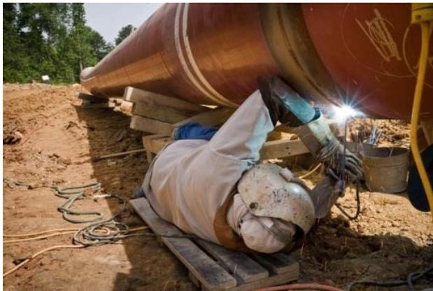
Figura 5. Vista geral do procedimento de soldagem de dutos com o processo eletrodo revestido na posição de soldagem sobre-cabeça
