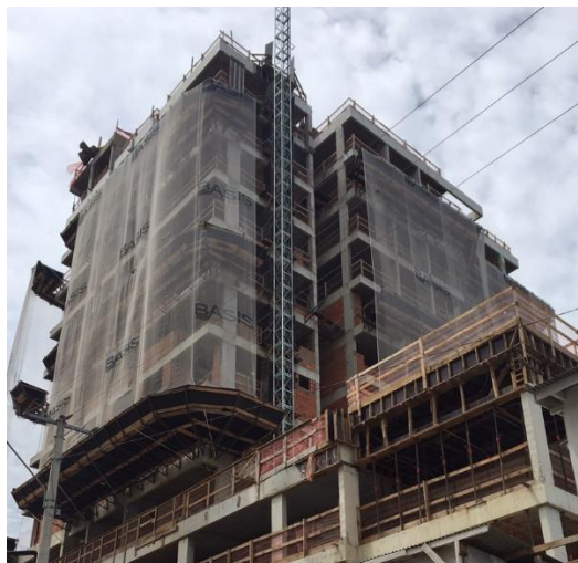
Figura 10 – Obra no início da pesquisa
