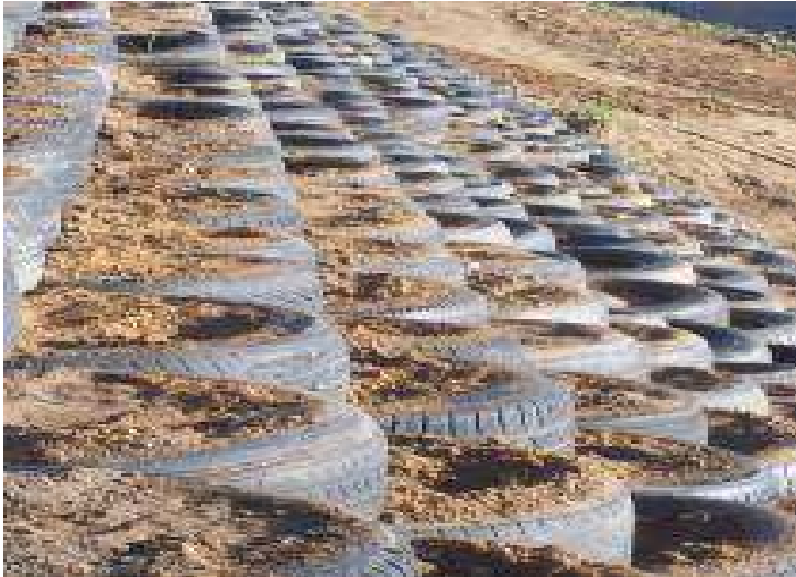
Figura 2 – Controle da Erosão
