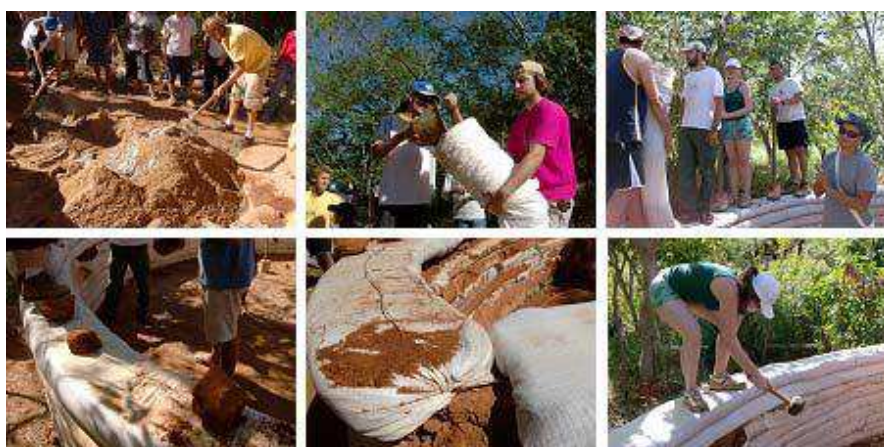
Figura 5 – Construção de parede estrutural em superadobe.
