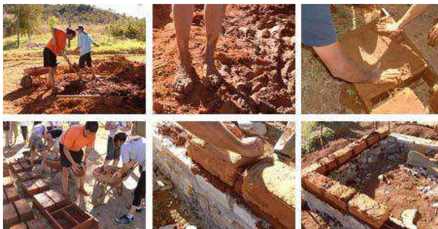
Figura 4 – Construção de blocos estruturais em adobe.
