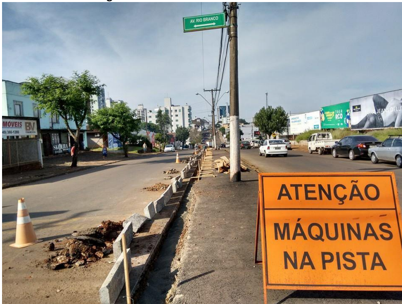
Figura 64. Obras da ciclovia na Av. Brasília.
