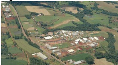
Figura 47. S. Industrial da Machado.
