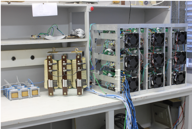
Figura 4.17 – Foto do protótipo trifásico com transformador de múltiplos enrolamentos.
