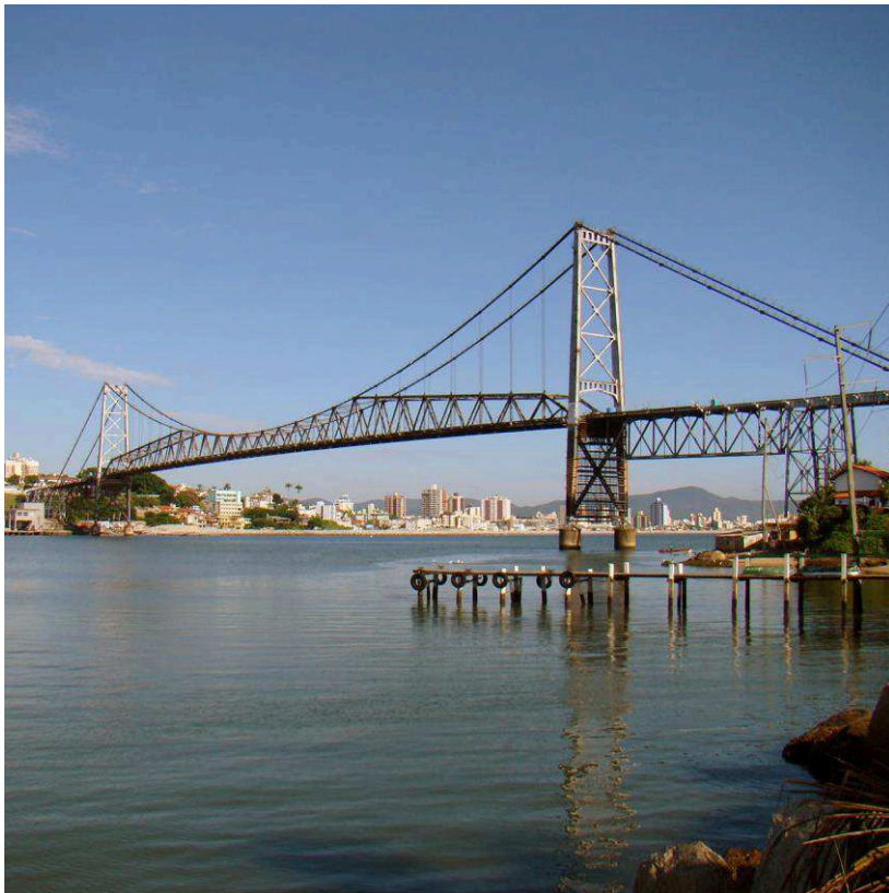
Figura 3 Ponte Hercílio Luz
