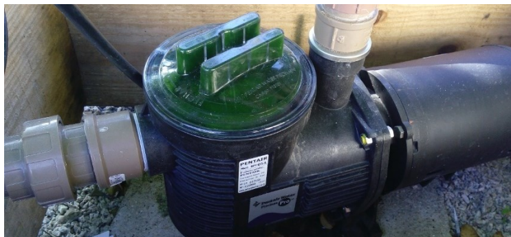
Figura 9 - Bomba hidráulica Pentair PBF-051 com pré-filtro e rotor fechado.
