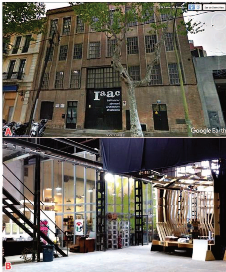
Figura 16 – Fachada do IAAC (A) e área interna pertencente ao Fab Lab Barcelona (B).
