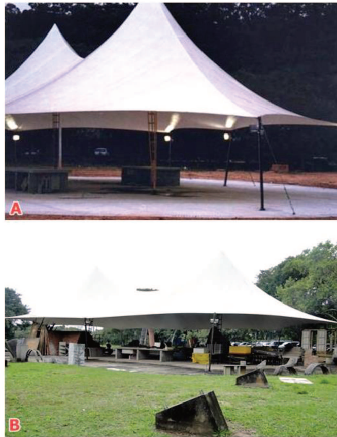
Figura 11 – Canteiro experimental em fase final de construção (A) e em funcionamento (B).
