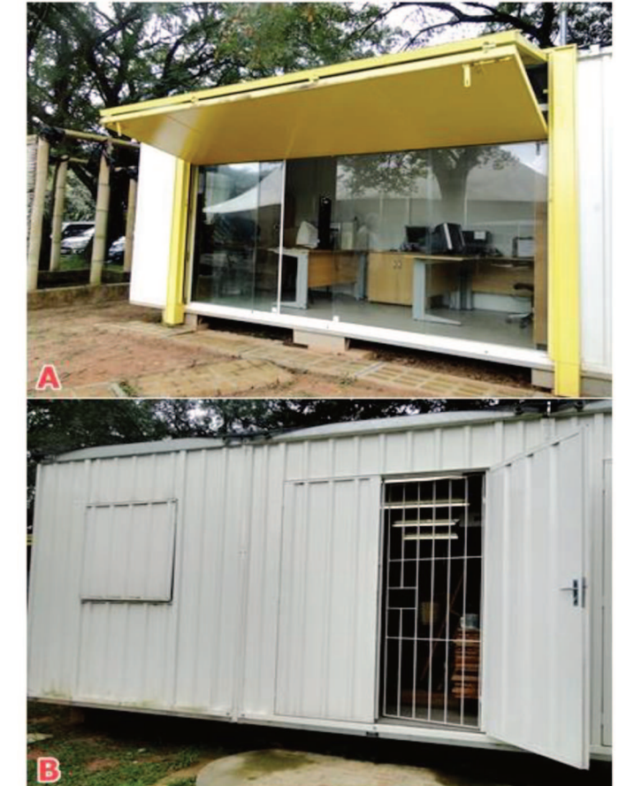
Figura 14 – Escritório (A) e almoxarifado (B) do canteiro.
