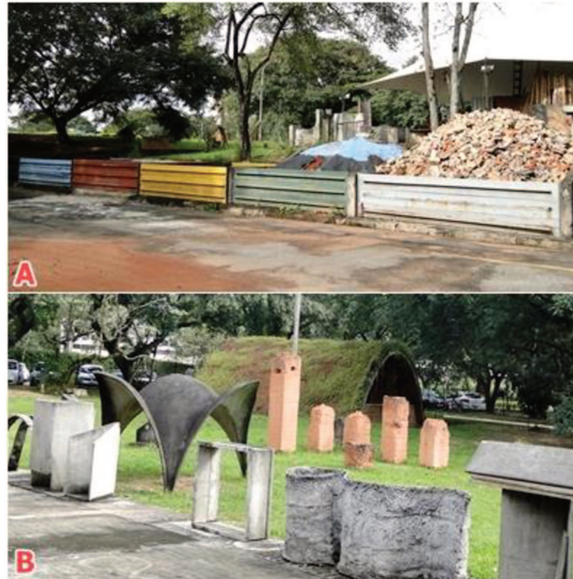
Figura 12 – Espaços internos do canteiro: baias para materiais a granel (A) e área descoberta para construção (B).
