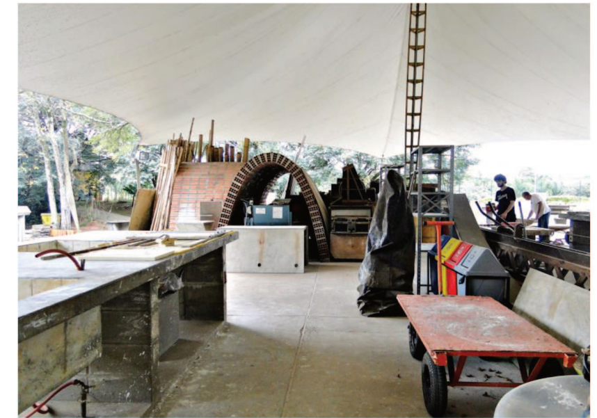
Figura 23 – Área coberta do canteiro.
