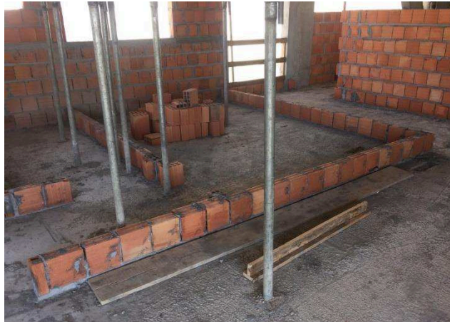
Figura 9 - Assentamento de blocos
