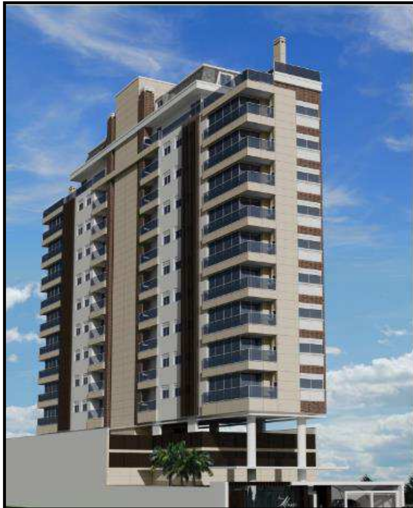
Figura 1 - Fachada do prédio
