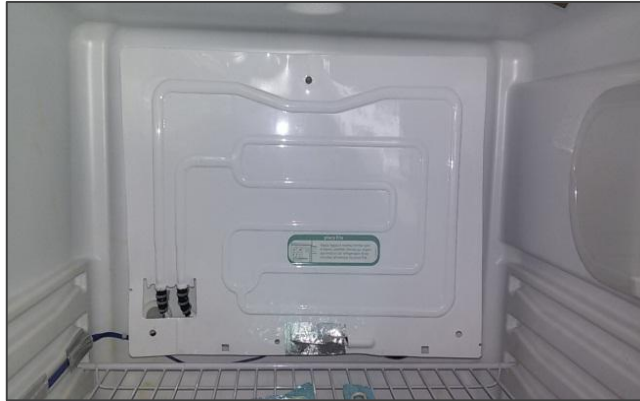
Figura 7 - Placa fria do refrigerador.
