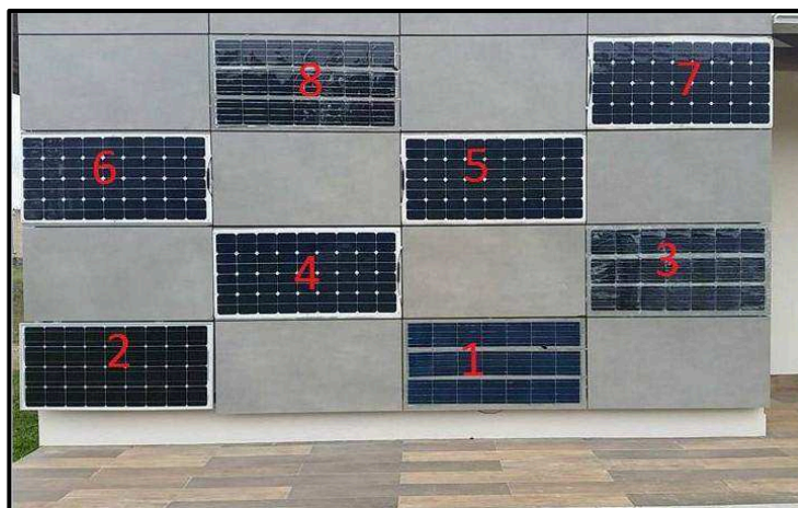
Figura 27 - Configurações dos módulos instalados.
