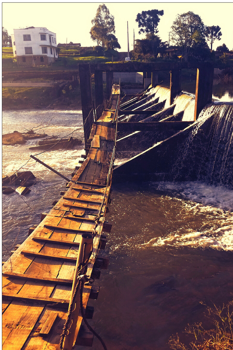
Ponte de acesso a outra margem está em situação precária e pode desabar
