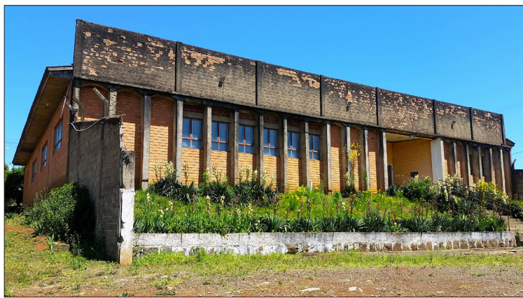
Problemas na estrutura estragam principal ambiente cultural de Lebon Régis
