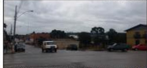
Construção das principais ruas, as antigas Santa Antônia e Arthur Barão, em maio de 2016
