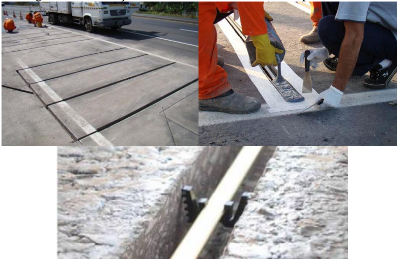
Figura 12 - Instalação de sistema WIM com sensores piezoelétricos.
