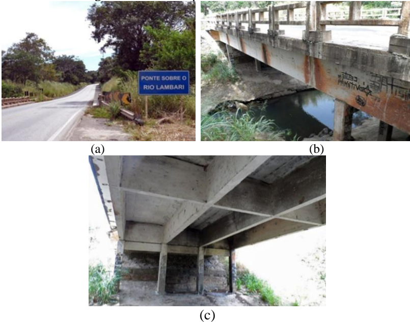
Figura 25 - Fotos da ponte sobre o Rio Lambari
