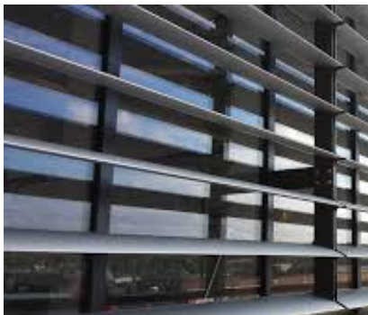
Figura 8. Dispositivo externo de sombreamento horizontal
