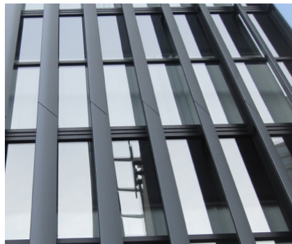
Figura 9. Dispositivo externo de sombreamento vertical
