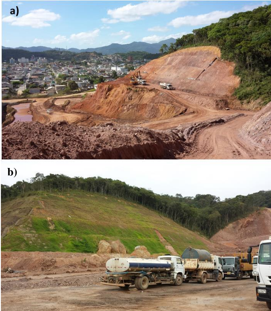
Figura 15. Aspecto geral do Talude Oeste, em dois momentos distintos a) durante a escavação das bancadas e b) geometria final.
