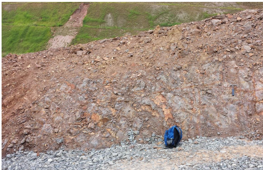
Figura 16. Aspecto do maciço rochoso aflorante próximo ao sopé dos taludes, exposto em virtude a instalação de obras locais.
