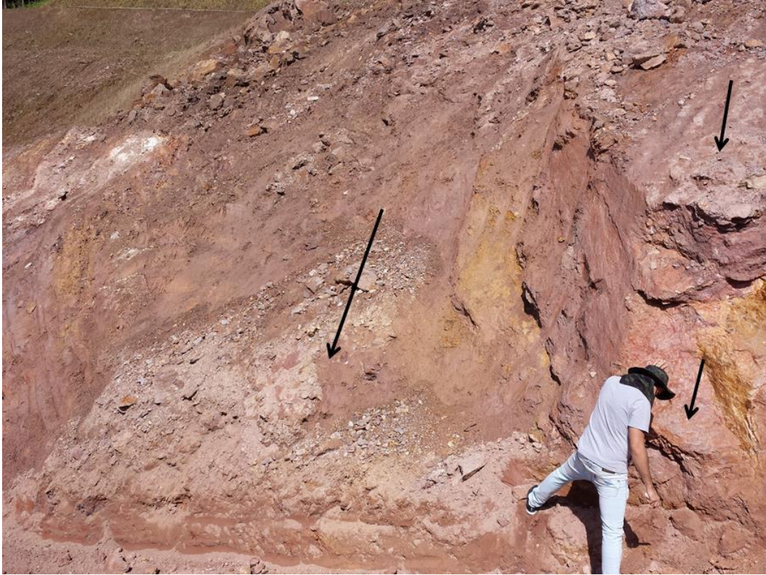
Figura 20. Rupturas planares rasas, com sentido de movimentação indicado pela seta preta.
