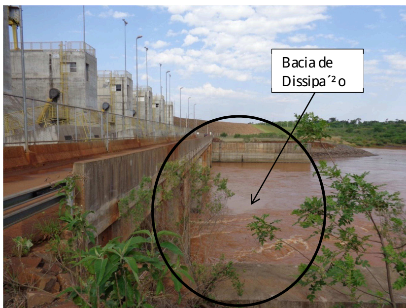
Figura 20 – Jusante do vertedouro, com destaque para a bacia de dissipa o - UHE de estudo de caso.
