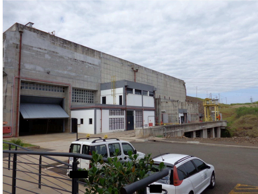
Figura 24 - Vista externa da casa de forçás - UHE de estudo de caso.
