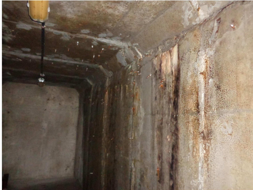
Figura 33 - Galeria do vertedouro com intensa umidade - UHE de estudo de caso.
