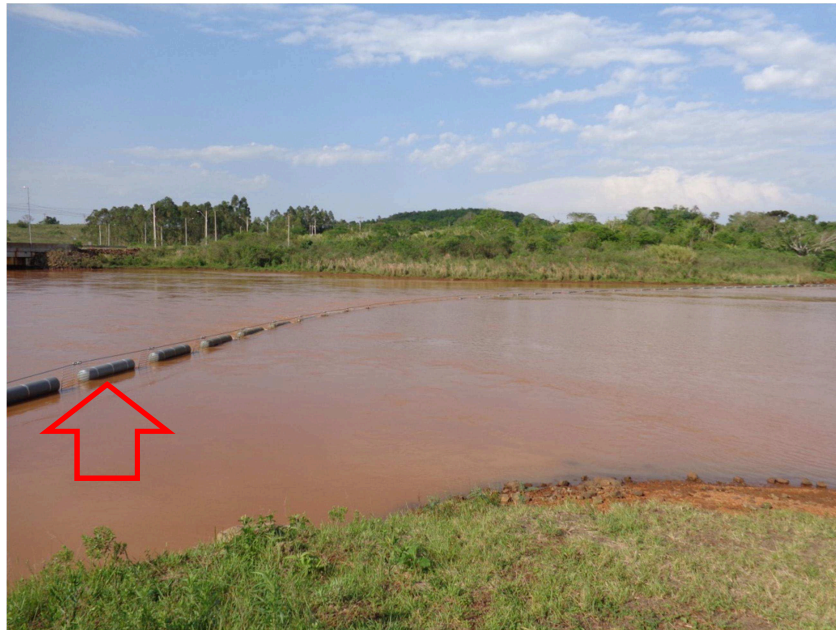
Figura 29 - Canal de adução com log boom (1) elevado (trecho da esquerda) - UHE de estudo de caso.
