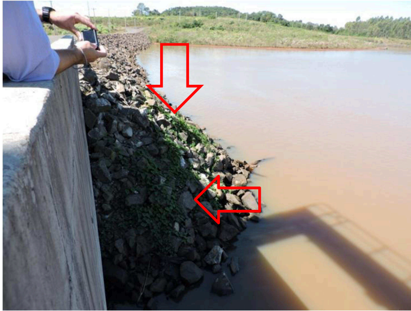
Figura 34 - Vegetação rasteira sobre o enrocamento no talude de montante da margem direita - UHE de estudo de caso.
