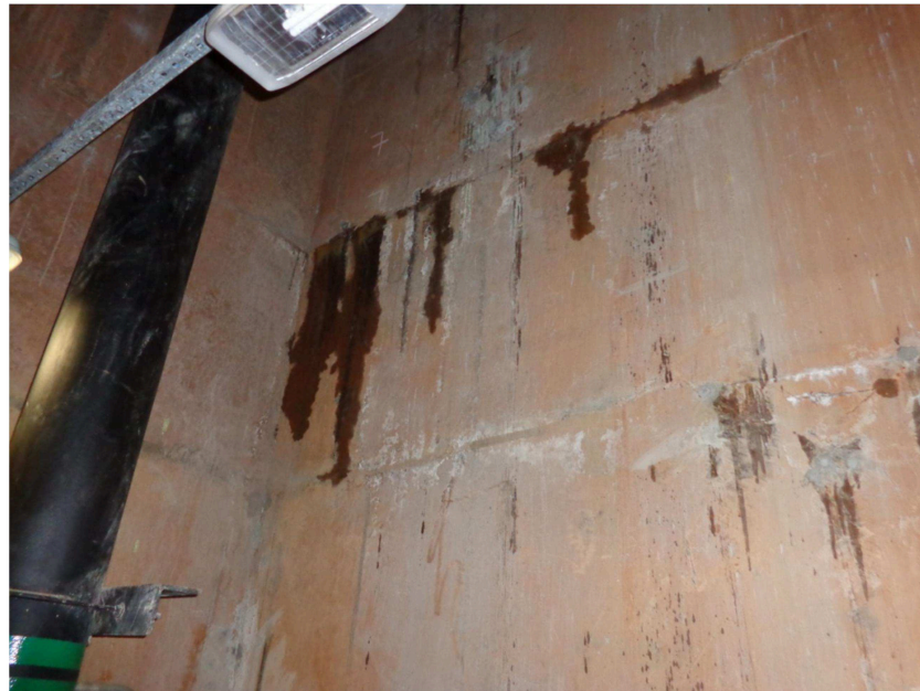
Figura 43 - Infiltração na parede de jusante do piso das bombas da casa de força. - UHE de estudo de caso.
