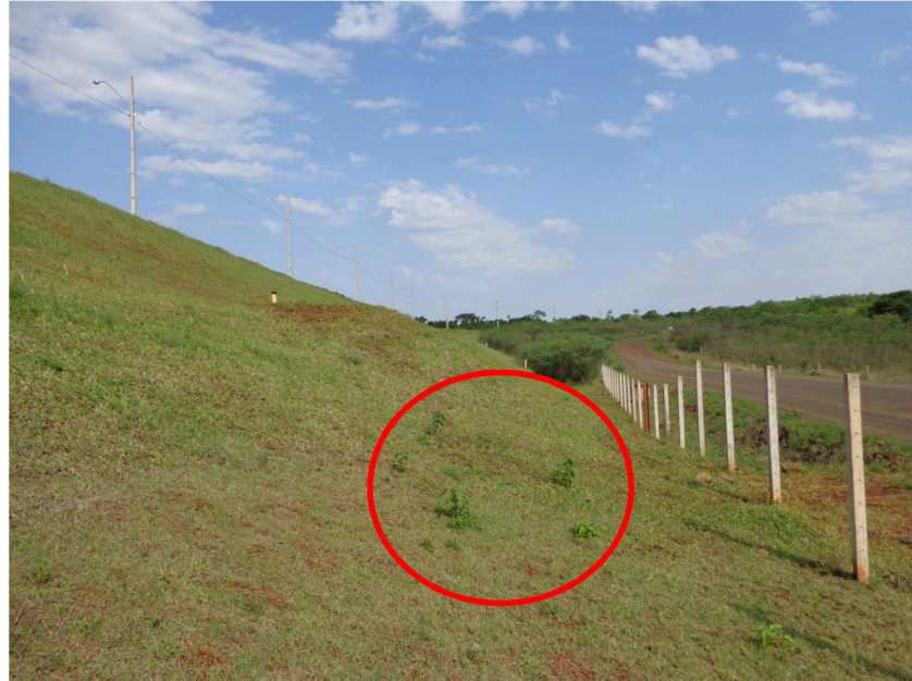
Figura 30 - Talude de jusante da margem esquerda da barragem de terra - UHE de estudo de caso.
