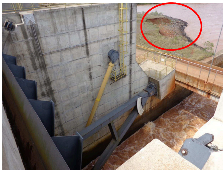
Figura 32 - Canal de restituição com margem esquerda erodida - UHE de estudo de caso.
