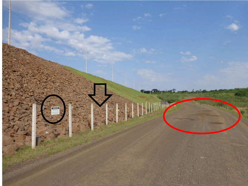
Figura 26 - Acesso - margem esquerda da barragem de terra - UHE de estudo de caso.
