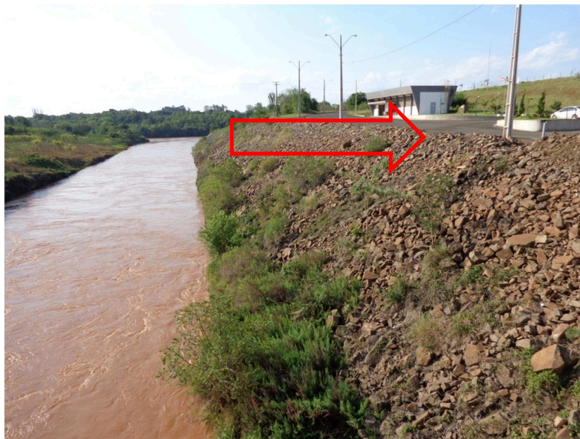
Figura 27 - Canal de fuga sem prote o lateral - UHE de estudo de caso.
