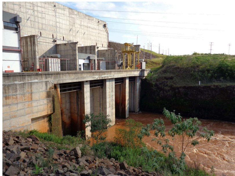
Figura 25 - Canal de fuga da UHE de estudo de caso.
