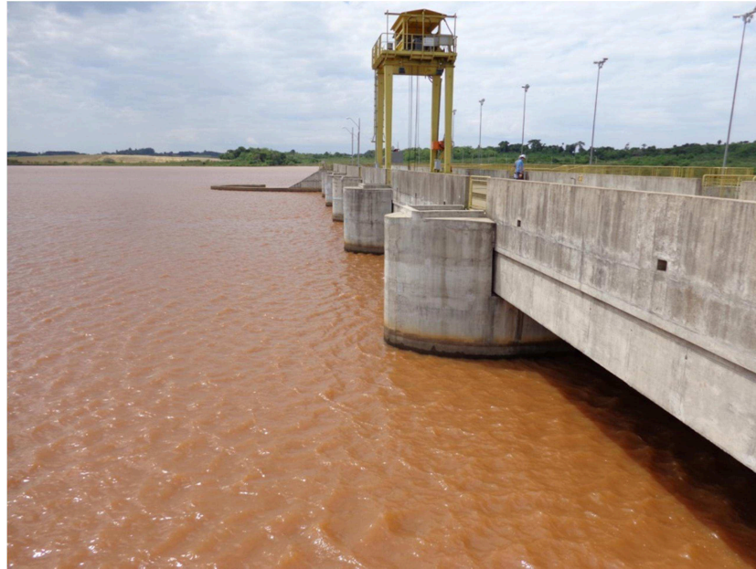
Figura 17 - Montante do vertedouro, com muro de aproximação ao fundo - UHE de estudo de caso.
