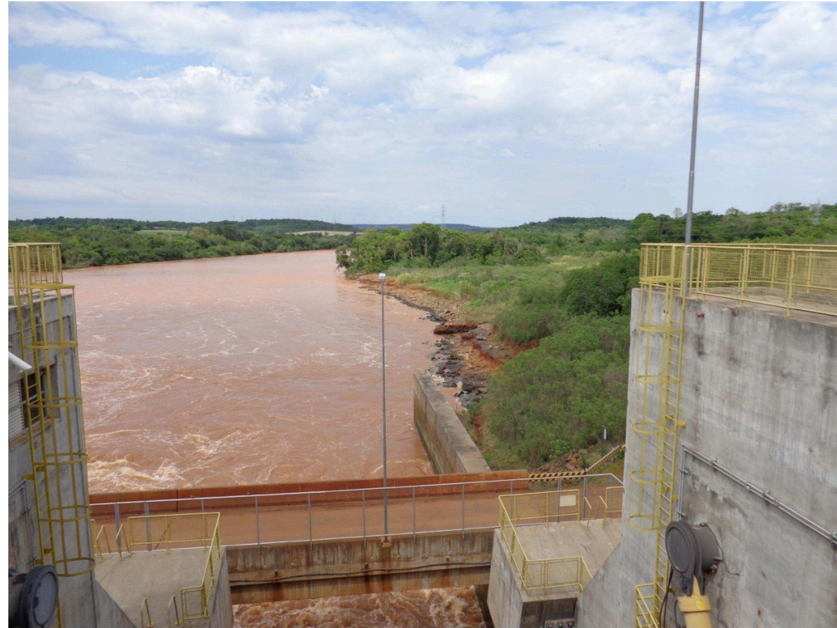
Figura 21 - Canal de restituição da água vertida - UHE de estudo de caso.
