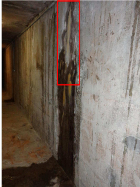
Figura 39 – Junta de dilatação entre casa de força e área de montagem. - UHE de estudo de caso.
