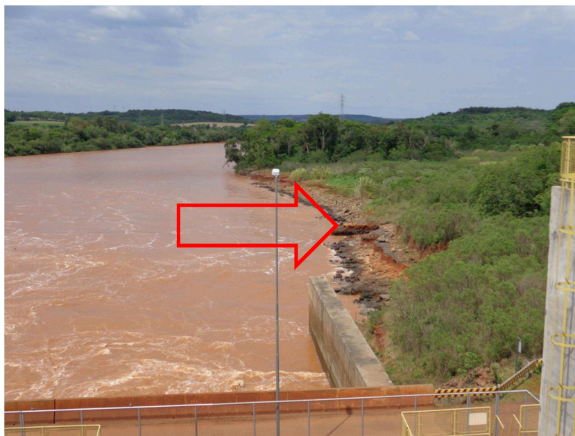
Figura 31 - Canal de restituição com margem direita erodida - UHE de estudo de caso.
