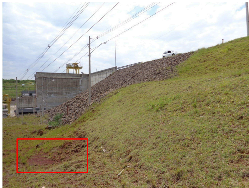
Figura 36 - Ausência de vegetação ao pé do talude de jusante - UHE de estudo de caso.
