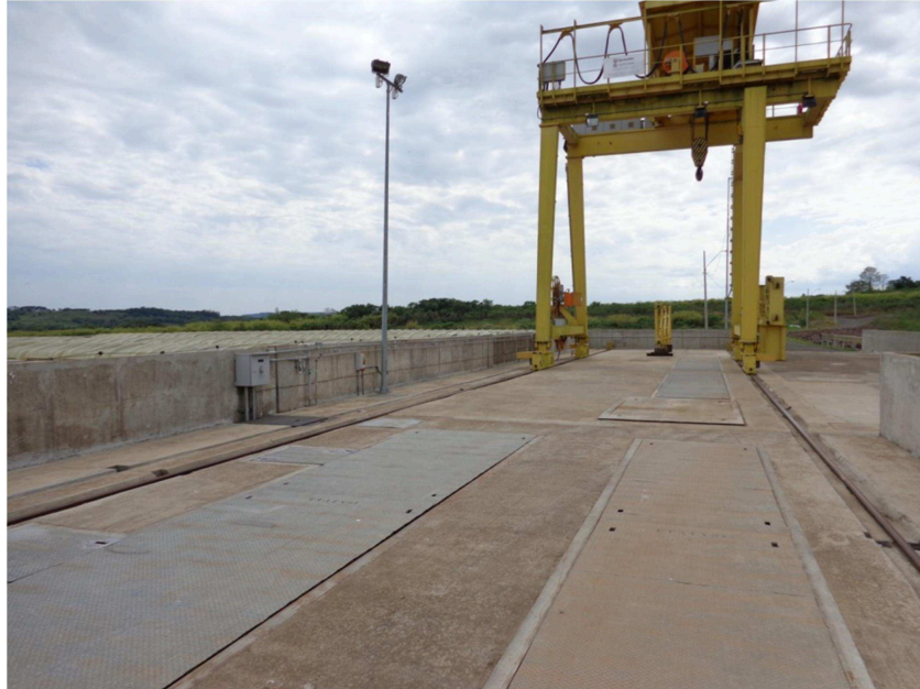
Figura 23 - Crista da tomada d'água com partição para içamento das comportas de manutenção - UHE de estudo de caso.
