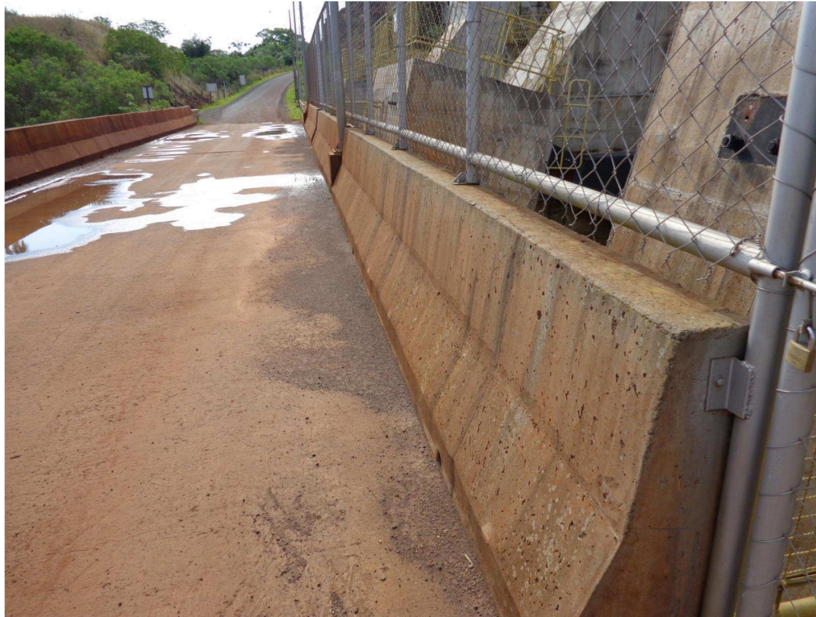
Figura 19 – Estrada de tr nsito de ve culos com grade de prote o para o vertedouro - UHE de estudo de caso.
