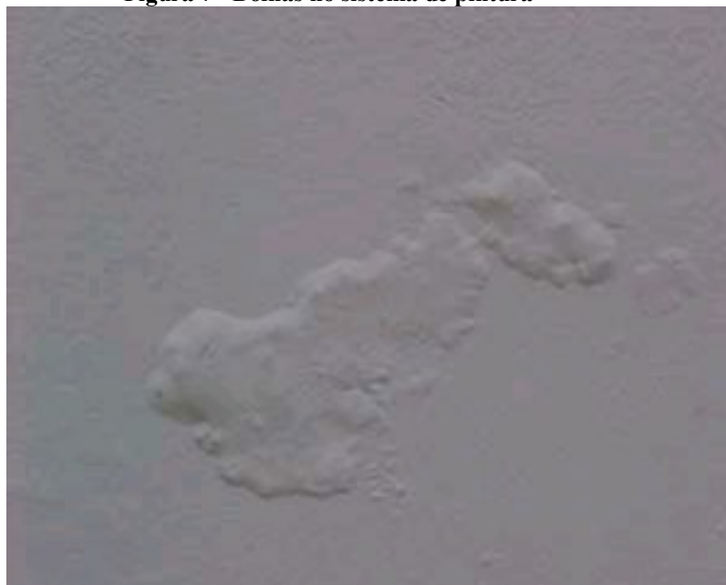
Figura 7 - Bolhas no sistema de pintura
