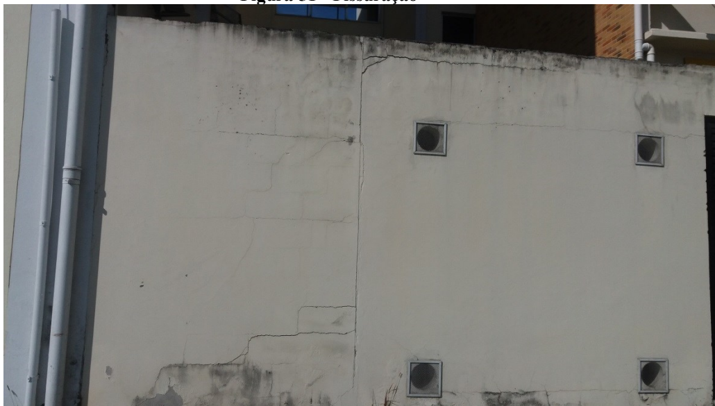
Figura 51 - Fissuração
