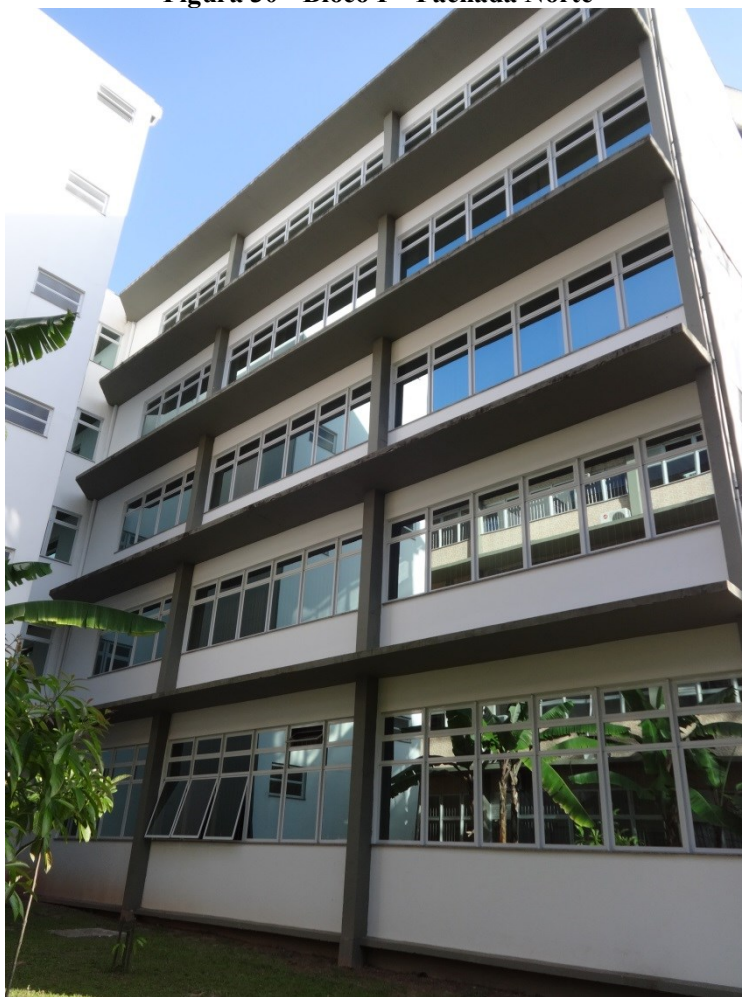
Figura 30 - Bloco I – Fachada Norte
