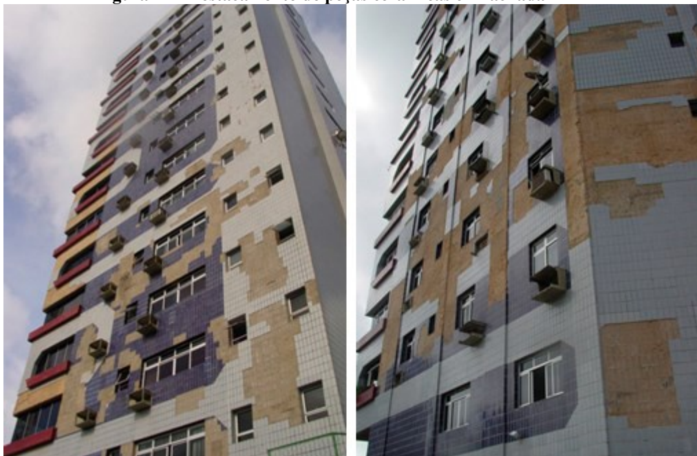
Figura 12 - Destacamento de peças cerâmicas em fachada
