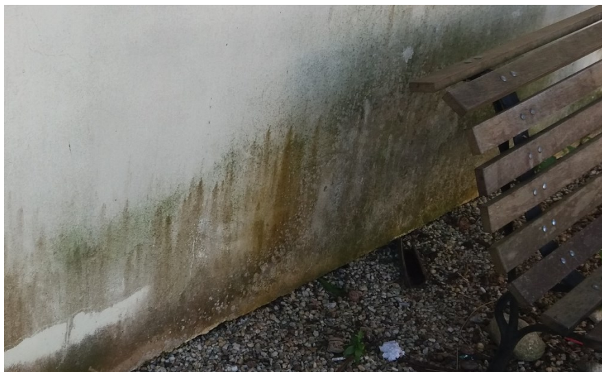
Figura 36 - Manchas esverdeadas, Bloco ENS (CTC)
