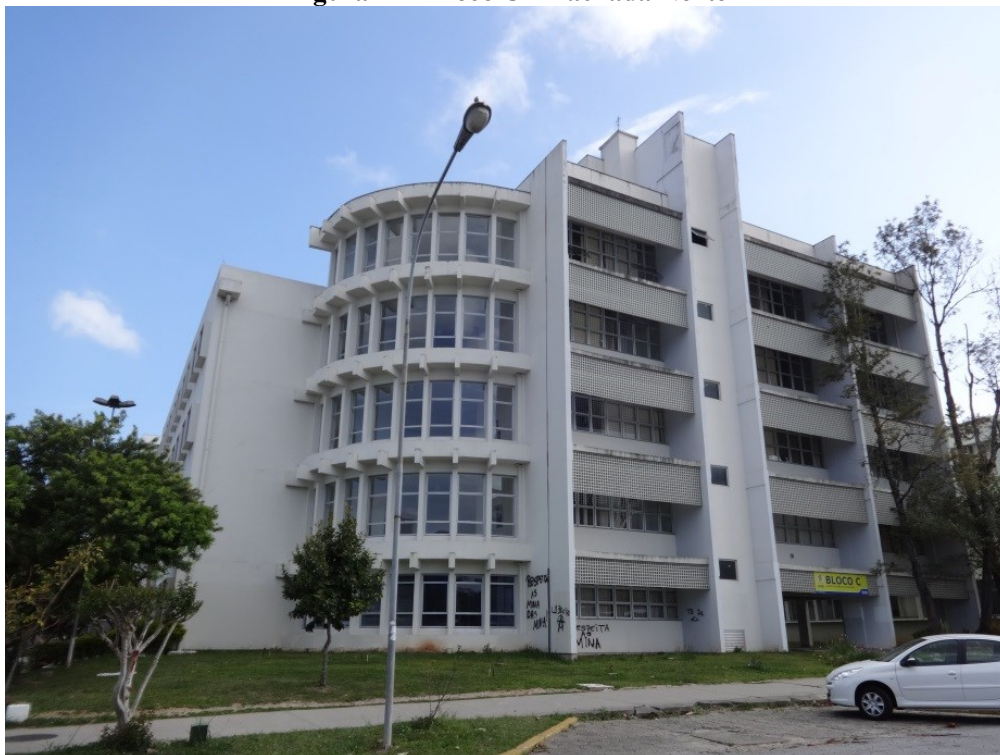
Figura 27 - Bloco C – Fachada Norte
