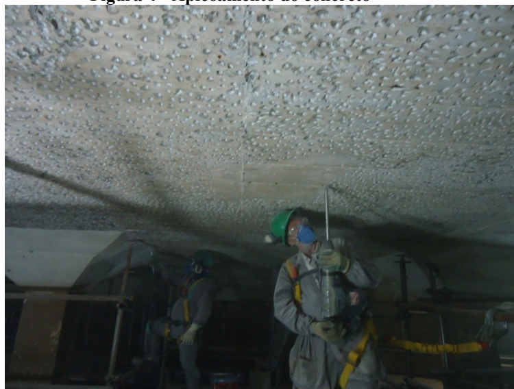
Figura 4 - Apicoamento do concreto
