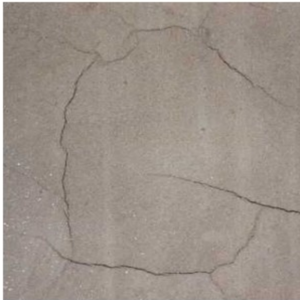
Figura 5 - Fissura na argamassa
