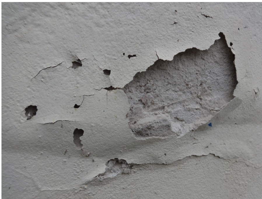
Figura 44 - Desprendimento de argamassa com pulverulência, Prédio ENS (CTC)
