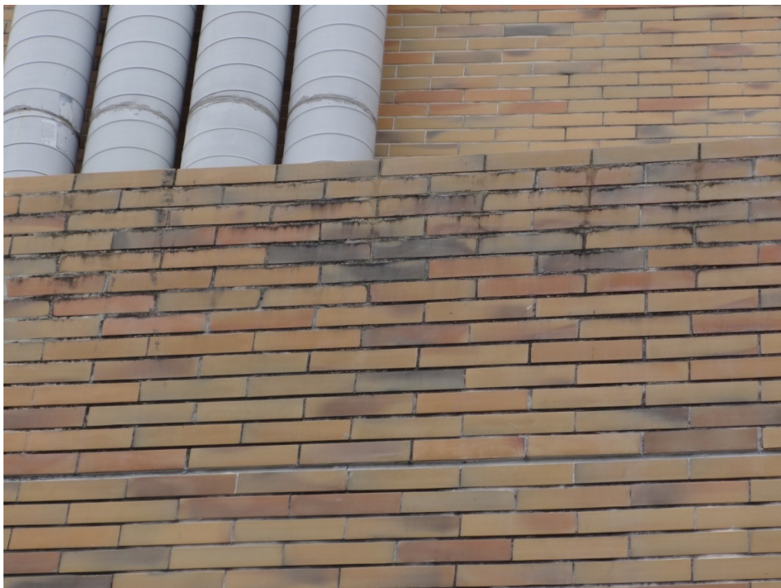
Figura 50 - Manchamento do rejunte e peças cerâmicas, Prédio ENS (CTC)
