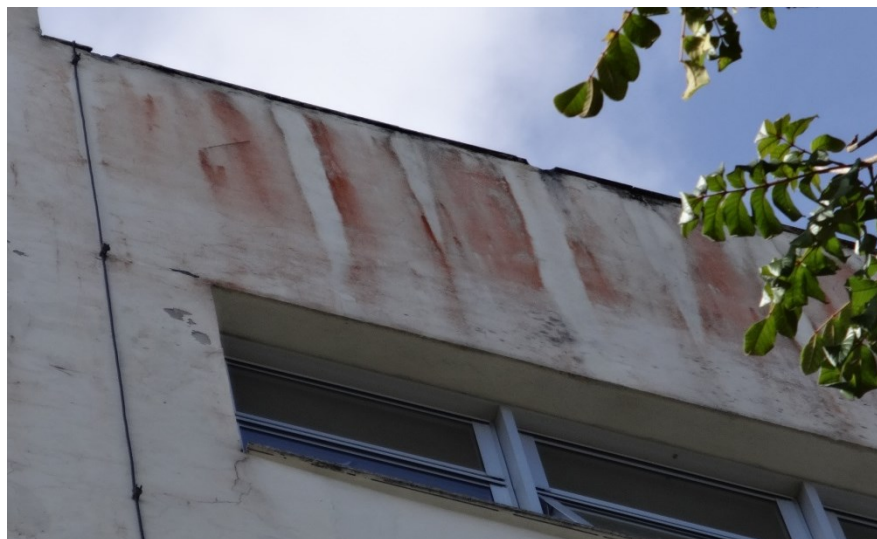
Figura 37 - Manchas vermelhas devido à algas, Bloco D (CED)
