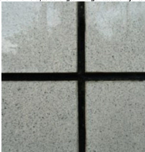
Figura 13 - Proliferação de fungos na argamassa de rejunte
