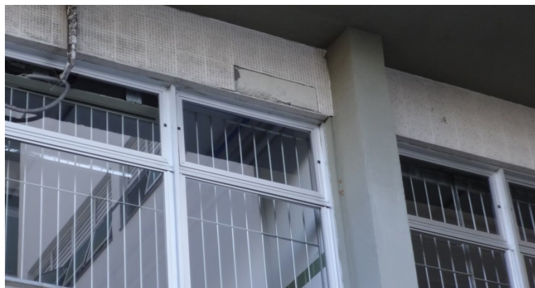
Figura 34 Descolamento de argamassa colante, Bloco H (CCS)
