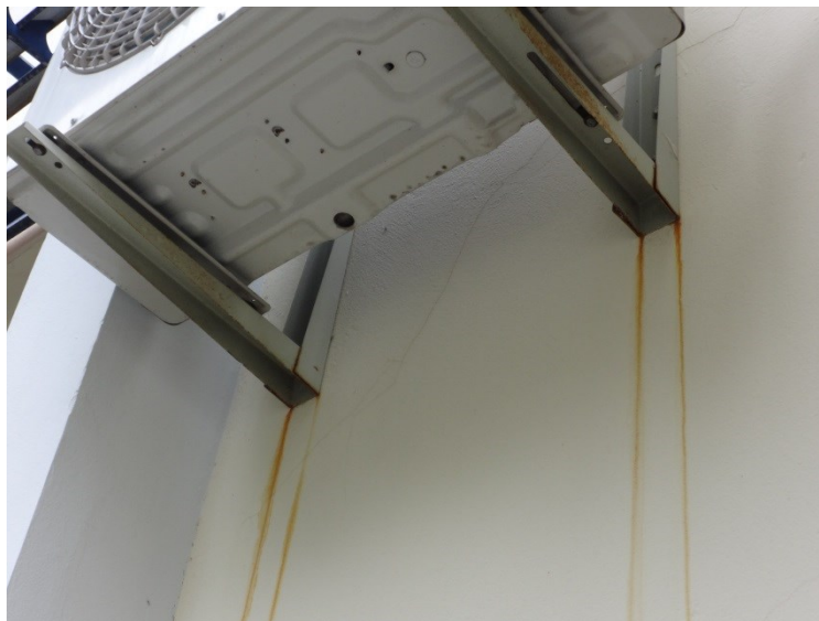
Figura 38 - Mancha devido à escorrimentos ferruginosos, Bloco ENS (CTC)
