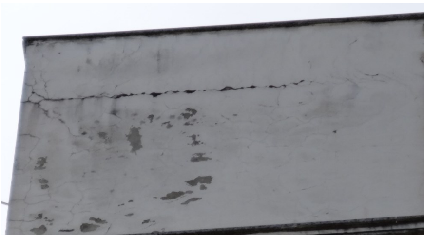
Figura 47 - Descascamento de pintura, Bloco C (CED)
