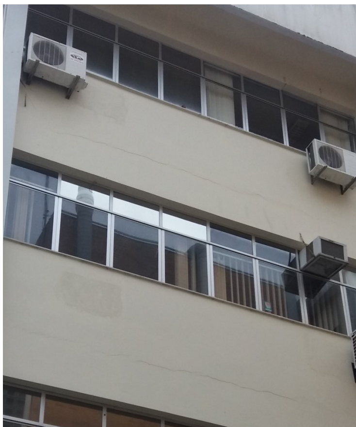
Figura 41 - Expansão da alvenaria devido absorção de umidade
