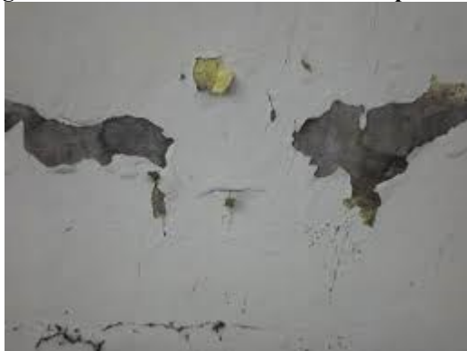
Figura 8 - Descascamento do sistema de pintura
