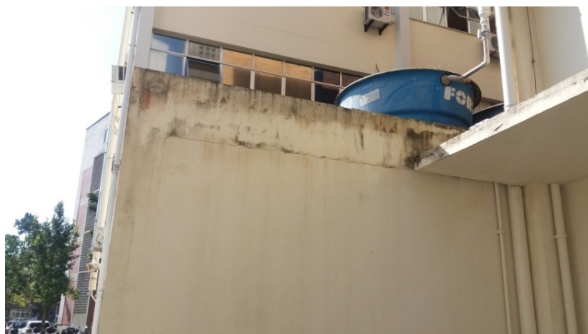
Figura 40 - Fissuras devido a Movimentação térmica da cobertura, Bloco ENS (CTC)
