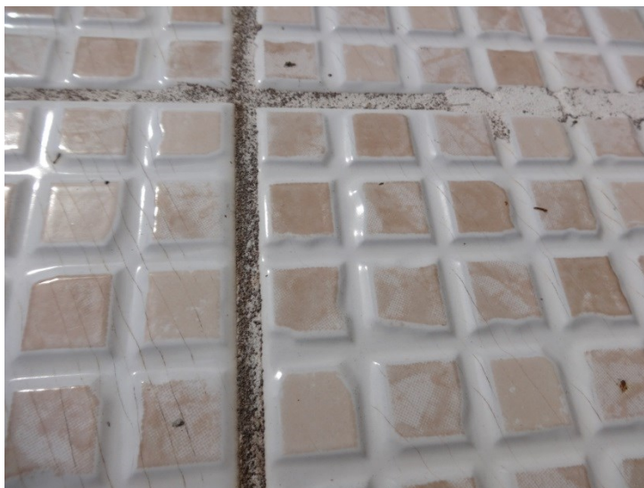
Figura 45 - Manchas devido à proliferação de fungos, Bloco H (CCS)
