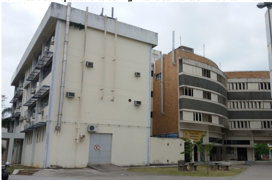
Figura 20 - Prédio do Departamento de Engenharia Sanitária e Ambiental – Fachada Oeste
