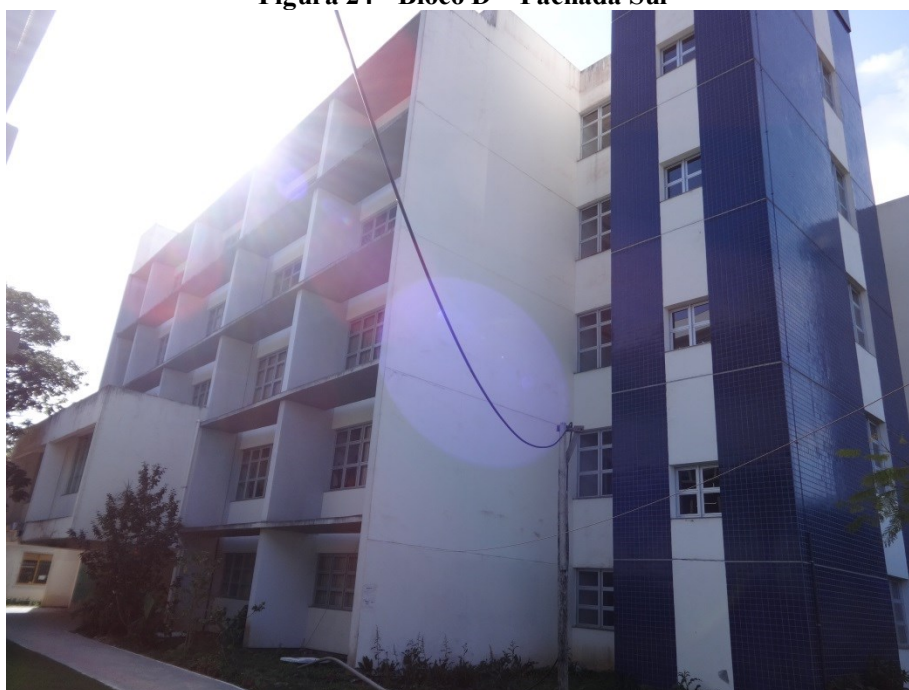
Figura 24 - Bloco D – Fachada Sul
