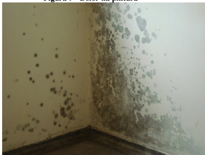
Figura 9 - Bolor na pintura
