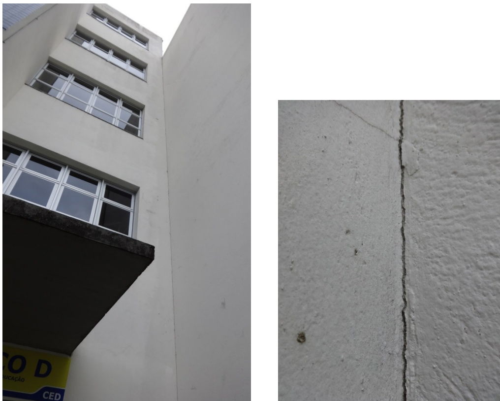
Figura 43 - Fissuração entre edificações, Bloco D (CED)
