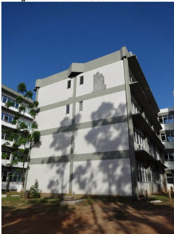
Figura 15 - Bloco H – CCS – Fachada Oeste
