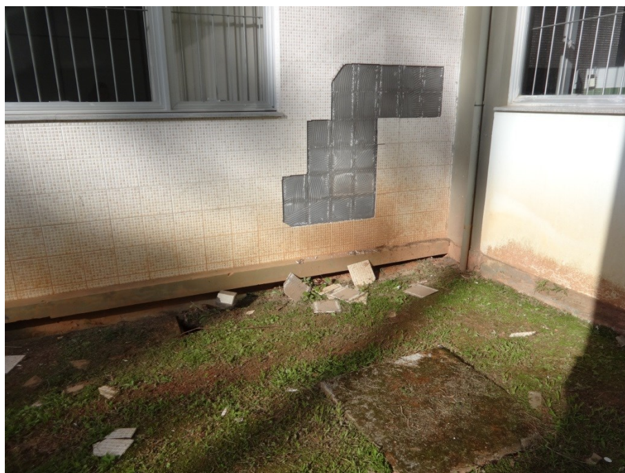
Figura 33 - Destacamento de peças cerâmicas, Bloco H (CCS)
