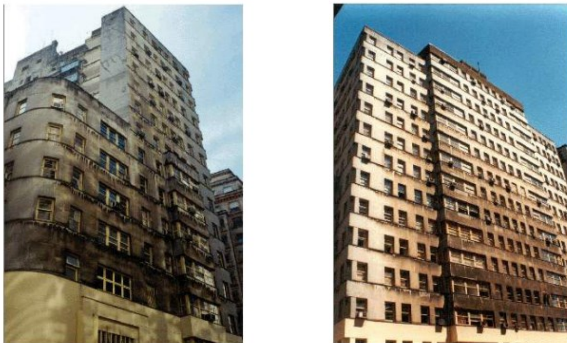
Figura 10 - Manchamento decorrente de contaminação atmosférica
