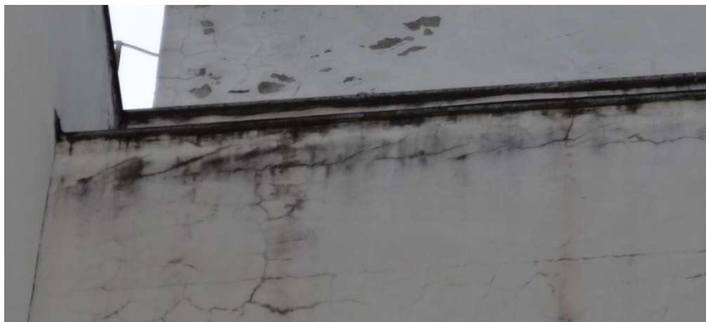
Figura 42 - Fissuras do tipo escama, Bloco C (CED)
