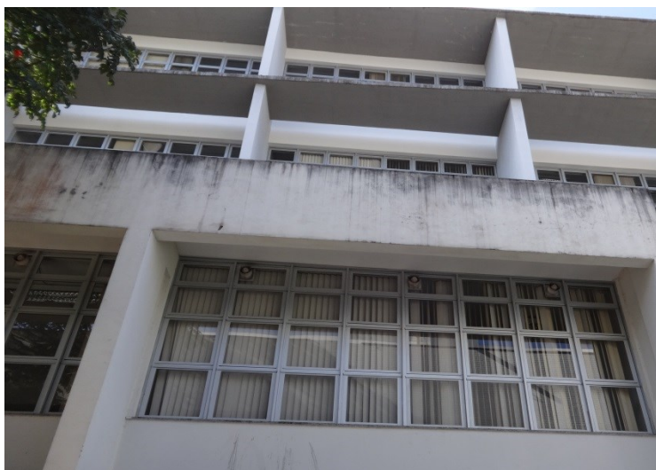
Figura 35 Manchas escuras, Bloco D (CED)
