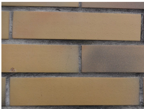
Figura 46 - Manchas devido ao acúmulo de sujeira, Bloco ENS (CTC)
