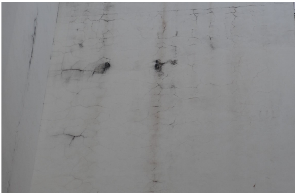
Figura 39 - Argamassa com fissuração mapeada, Bloco C (CED)
