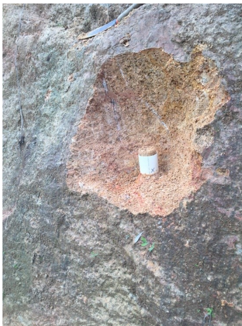
Figura 24 - Talude com características distintas no ponto 4.
