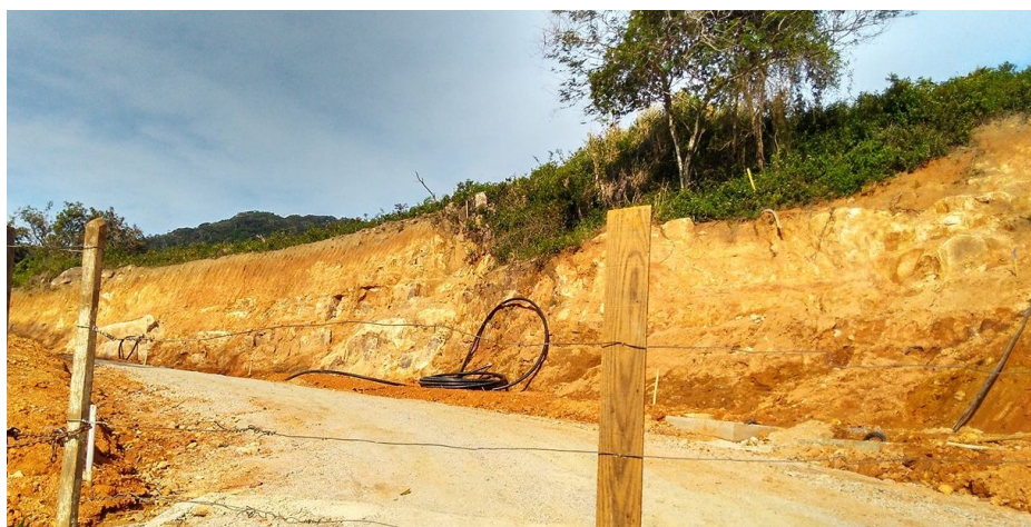
Figura 20 - Cortes realizados no segundo ponto de coleta para obras de infraestrutura.
