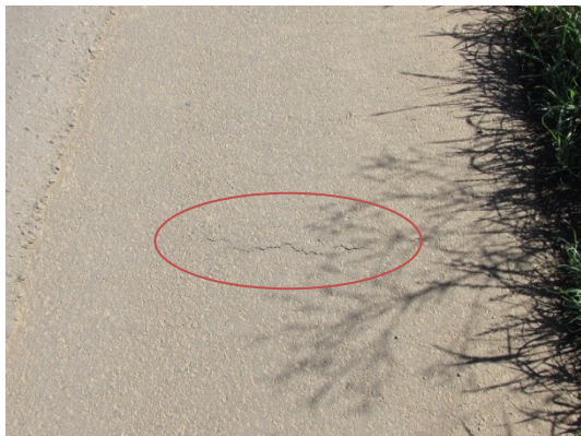
Figura 63 - Sentido BR 282 – BR 153, quilometro 2,728 – trinca transversal curta no acostamento
