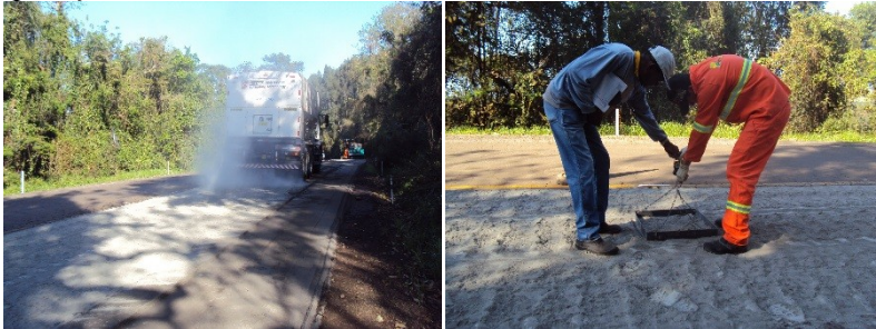
Figura 30 - (a) Espalhamento do cimento, (b) Verificação da taxa de aplicação do cimento
