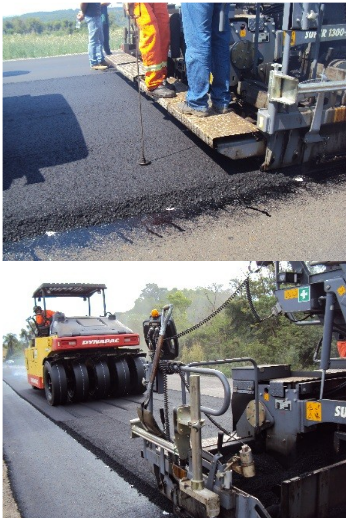
Figura 34 - (a) verificação da espessura de lançamento (b) compactação da camada de rolamento
