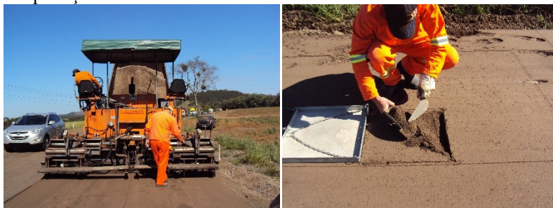
Figura 29 - (a) Distribuição do agregado virgem, (b) verificação da taxa de aplicação
