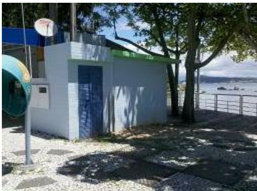
Figura 2- Elevatória de Esgoto J2A, Bom Abrigo (Fonte: CASAN).
