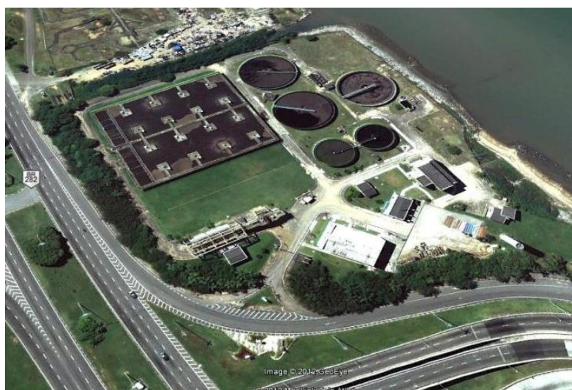
Figura 4- ETE Insular (Fonte: Diário Catarinense).
