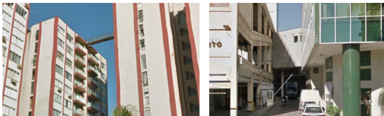
Figura 59 - Passarela entre prédios em condomínio (esq.) e passarela entre Shopping Muller e Hotel Bourbon (dir.), Joinville-SC.
