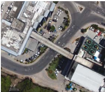
Figura 54 - Passarela sobre a Av. Beira Rio, Cidade do Recife-PE. Fonte: Google Earth
