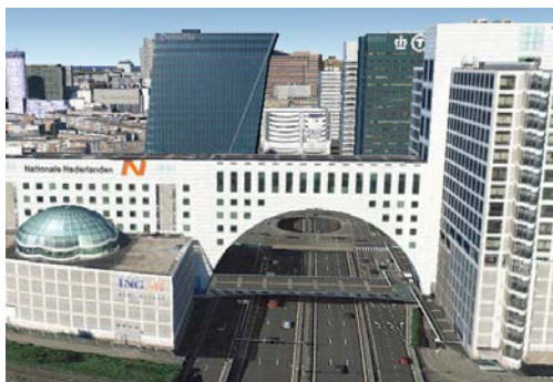
Figura 30 - Edifício da empresa Nationale-Nederlanden sobre a rodovia Utrechtsbaan, Haia, Holanda. Fonte: Google Earth.
