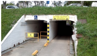
Figura 75 - Passagem subterrânea, entrada Leste.
