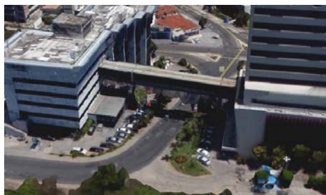
Figura 55 - Passarela interligando os Hospitais Hope e Esperança, cidade do Recife-PE. Fonte: Google Earth.
