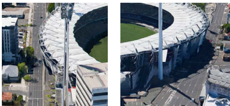
Figura 33 - The Gabba Cricket Stadium, Brisbane, Austrália. À esquerda, construção sobre a Vulture Street; à direita, sobre a Stanley Street. Fonte: Google Earth.
