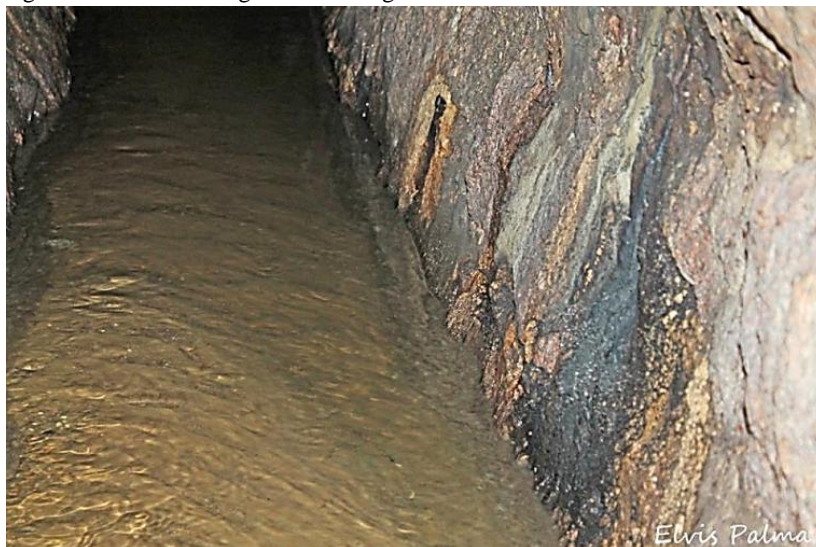
Figura 145: Vazão da água dentro da galeria.
