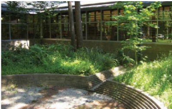
Figura 23: Jardim de chuva da Biblioteca Maple Valley, Maple Valley, Washington/EUA.
