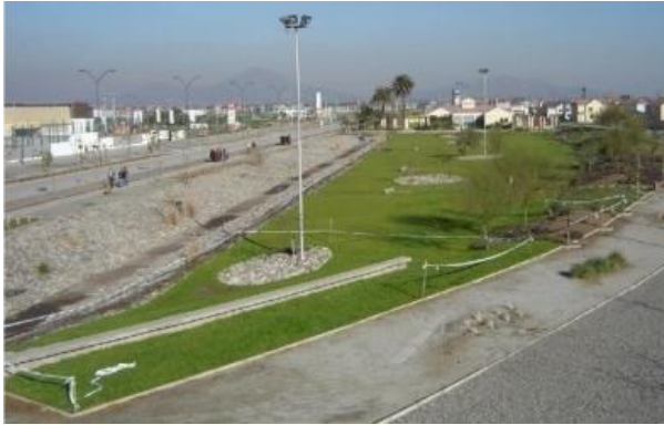
Figura 30: Bacia de detenção, Santiago do Chile .
