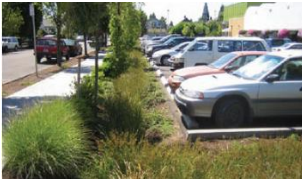
Figura 27: Biovaleta do estacionamento do New Seasons Market, Portland, Oregon/EUA.
