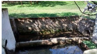
Figura 13: Tubulação ao lado da Fonte da Carioca, Centro, Laguna/SC. Detalhe da tubulação de saída em direção à Lagoa Santo Antônio dos Anjos.
