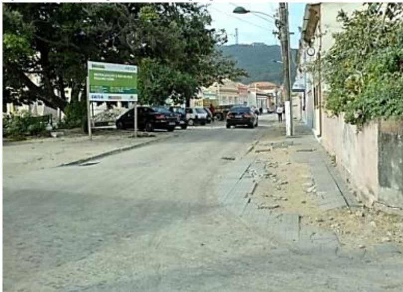
Figura 140: Praça República Juliana, perspectiva do início da obra.
