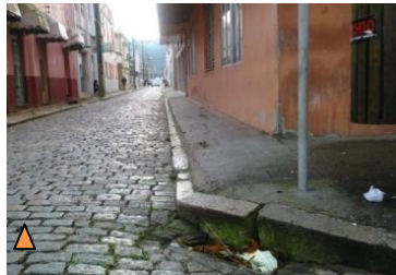
Figura 133: Rua Raulino Horn, Centrão Lanches, exemplar art deco .
