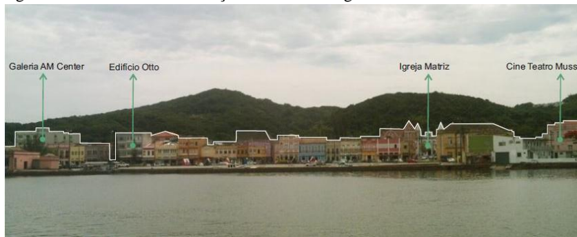
Figura 97: Gabarito das edificações – vista da Lagoa Santo Antônio.
