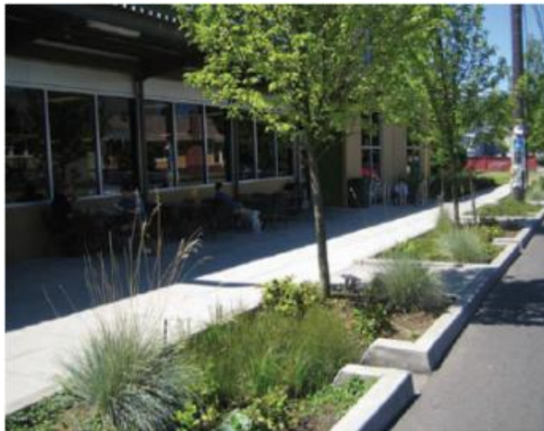
Figura 25: Canteiros Pluviais junto do New Seasons Market, Portland, Oregon/EUA.
