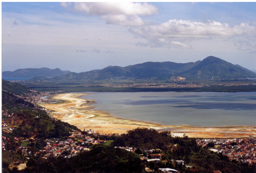
Figura 3.09: Aterro da Via Expressa Sul. Fonte: Portal Aterros em Florianópolis.
