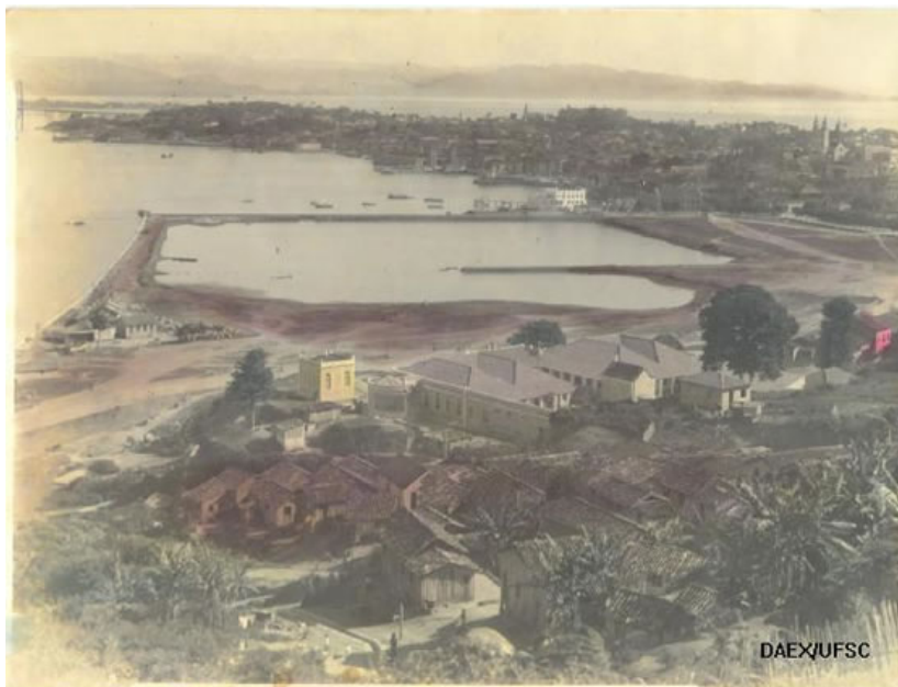
Figura 3.05: Execução do primeiro grande aterro de Florianópolis, em 1943. Fonte: Portal Velho Bruxo
