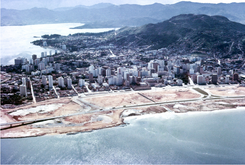
Figura 5.07: Execução do aterro de 1973 que cortou definitivamente as relações da cidade com o mar em sua porção mais central.
