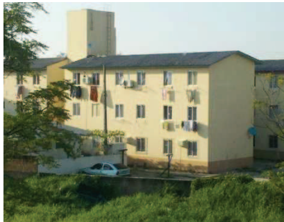
b) edificação de interesse social
