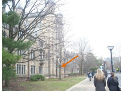
Figura 45 - Entradas principais- edifício é mais alto na parte sobre a entrada
