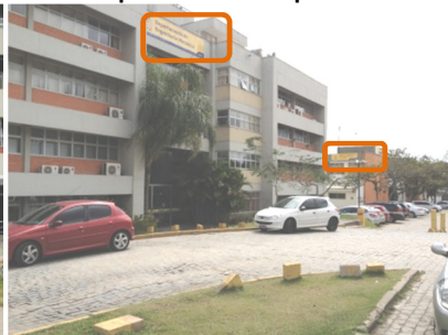
Figura 138 - CTC: placas identificativas instaladas no topo das edificações, fora do campo de visão dos pedestres 02
