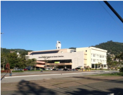
Figura 40 - Centro de Cultura e Eventos, edificação cognominada de "Elefante Branco", devido à demora na conclusão das obras
