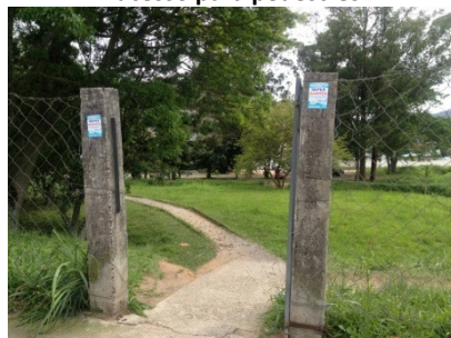
Figura 116 - Limite dos setores B e C: acesso para pedestres
