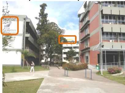
Figura 137 - CTC: placas identificativas instaladas no topo das edificações, fora do campo de visão dos pedestres 01
