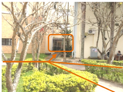
Figura 108 - Caminho conduz os pedestres a acesso desativado [CTC]
