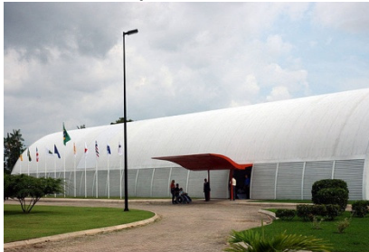
Figura 46 - Entrada Hospital Sarah Kubitschek - Belém, PA
