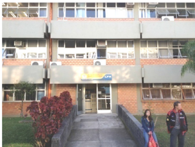
Figura 134 - CFH: Entrada da biblioteca - Ausência de diferenciação/marcação na fachada
