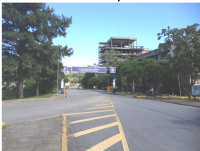
Figura 113 - Pórtico de acesso (Bairro Pantanal)
