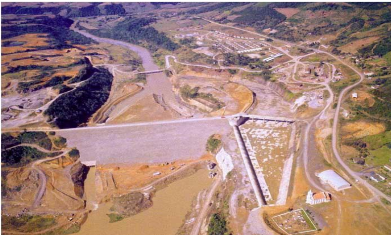
Figura 12: Barragem Norte - José Boiteux/ Autor: Construtora Camargo Correa
