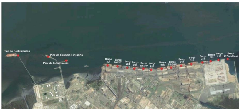
Figura 5 – Localização dos berços e píeres do Porto de Paranaguá
