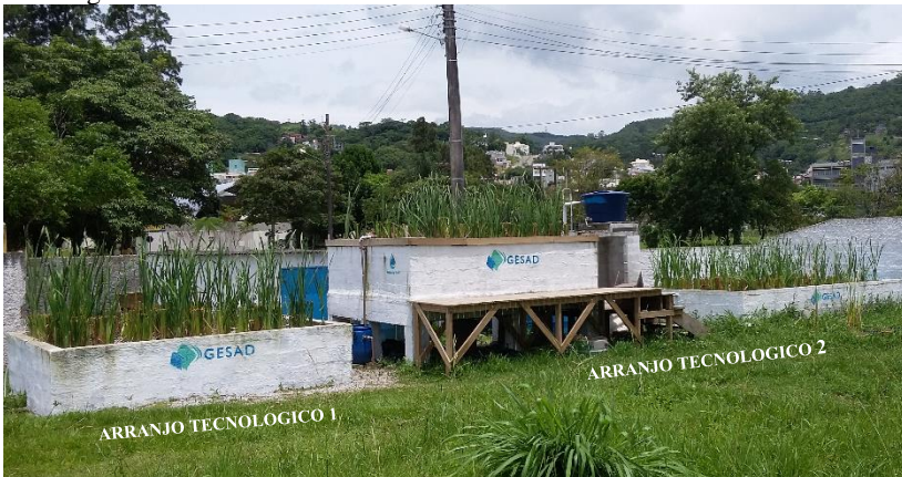
Figura 7. Foto da Estação piloto de tratamento de esgoto mostrando os arranjos tecnológicos
