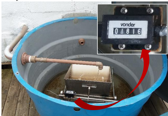
Figura 14. Dispositivo instalado para auxiliar no cálculo do volume afluente ao WCH (instalado a jusante do WCVD).
