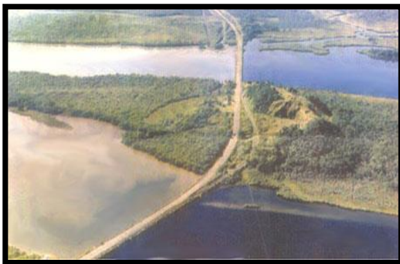
Figura 8: Vista geral do aterro no Canal do Linguado (Fonte: Sonar Comunicação).
