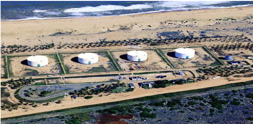
Figura 41: Imagem aérea porto de Regência ES, mostrando quatros tanques para armazenagem de petróleo com capacidade nominal de 40.000 m 3 .
