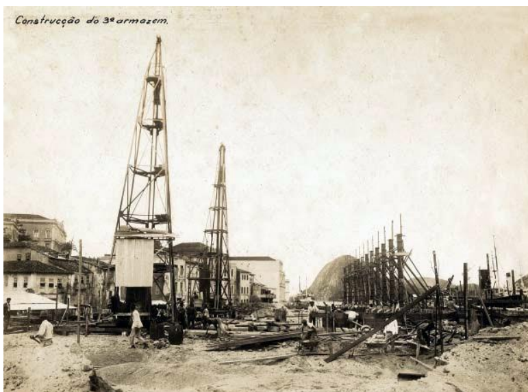
Figura 26: Construção do armazém 3 do porto público de Vitória. Anos 40.
