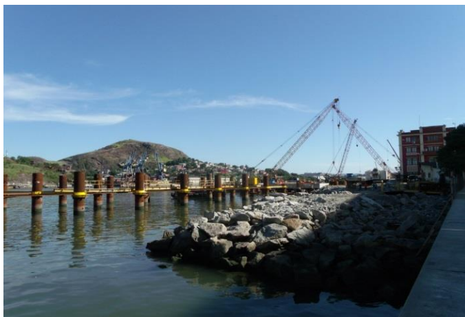
Figura 27: Ampliação do Cais Comercial do Porto de Vitória, ano de 2012.
