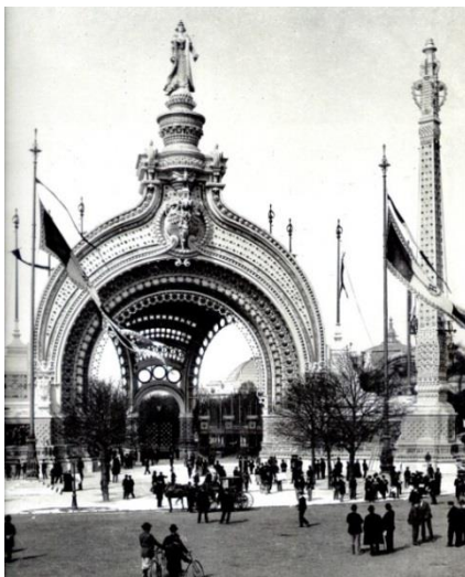
Figura 45. Projet pour la porte monumentale de l'exposition universelle de 1900 , em torno de 1898. René Binet.
