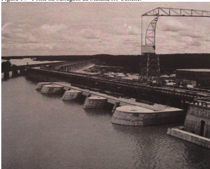
Figura 14 - Ponte na barragem da Matala, rio Cunene.
