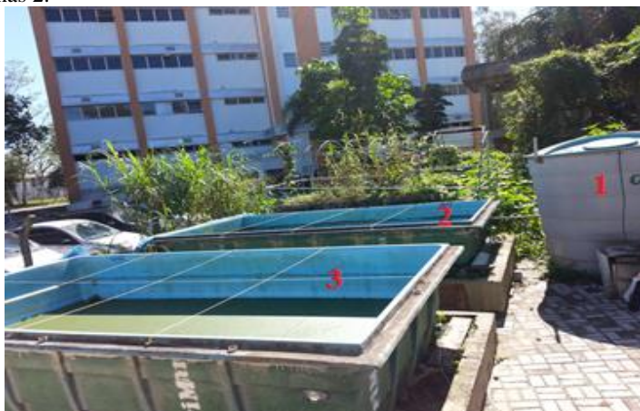
Figura 4 – Imagem do sistema de tratamento com lagoas de lemnas em escala piloto, onde: 1) Tanque de equalização; 2) Lagoa de Lemnas 1; 3) Lagoa de Lemnas 2.
