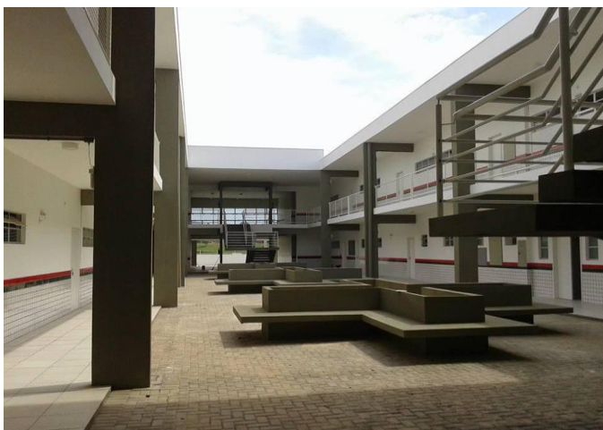
Figura 8- Pátio interno da EEMTS.
