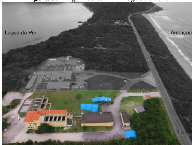
Figura 3: Imagem aérea ETA Lagoa do Peri.
