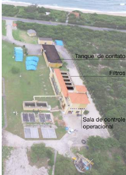
Figura 4: Imagem aérea ETA Lagoa do Peri com destaque para sala de controle operacional, os filtros e o tanque de contato.
