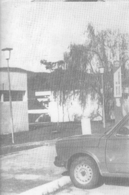
Centro de Ciências Biológicas da UFSC: construído em solo-cimento em 1967.
