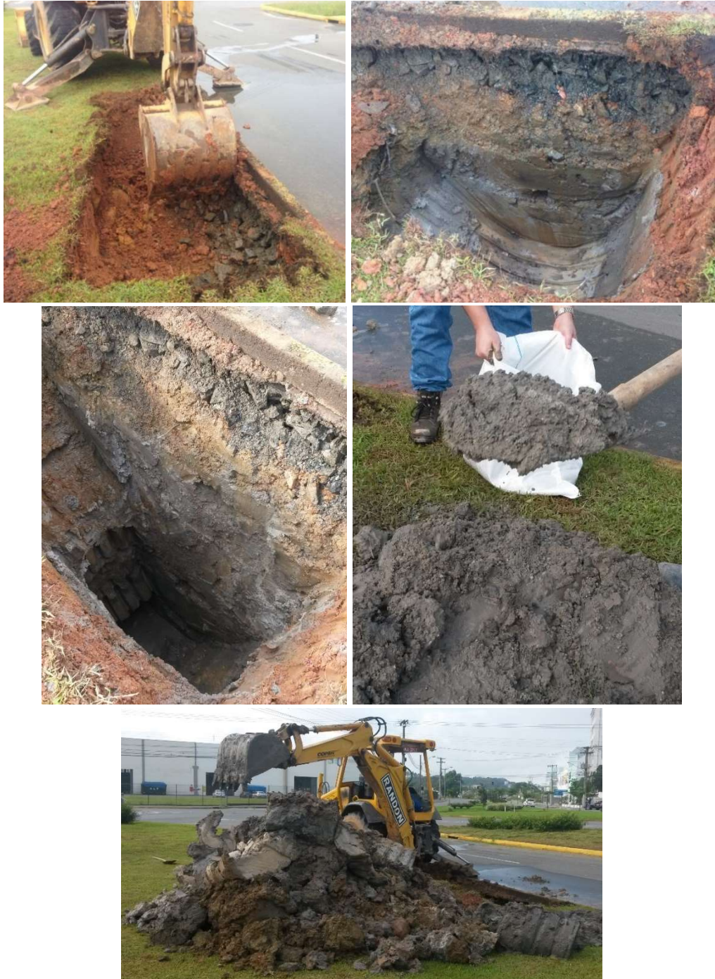
Figura 19 – Processo de escavação e coleta do solo do subleito.
