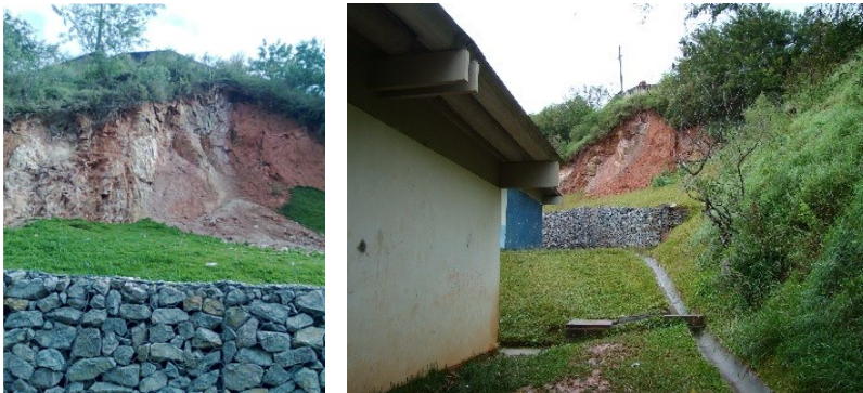
a) Vista frontal do talude; b) Vista ampla.
