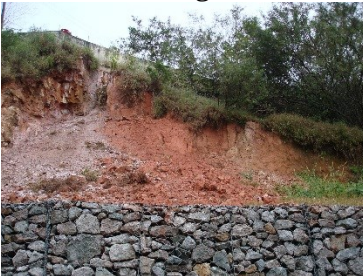
a) Bloco de solo que deslizou; Fonte: Maccarini (2010).
