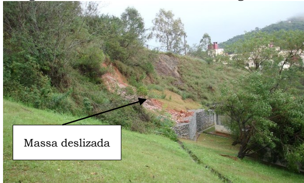
Figura 32. Vista do terceiro escorregamento.
