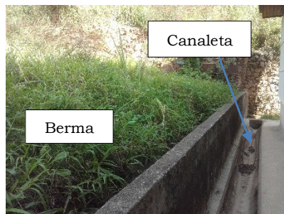
Figura 28. Vista da berma e detalhe da canaleta.
