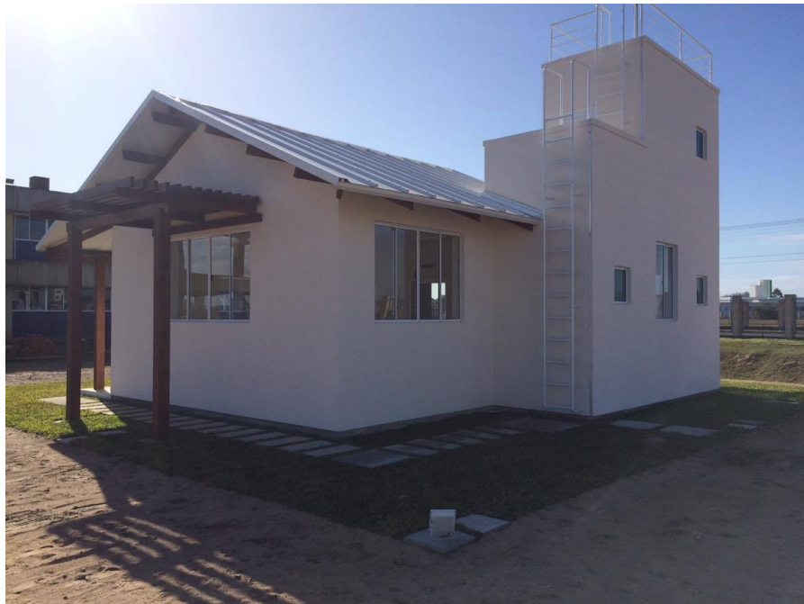
Figura 15 - Fachadas sul e oeste da planta piloto (Fonte: Arquivo pessoal).
