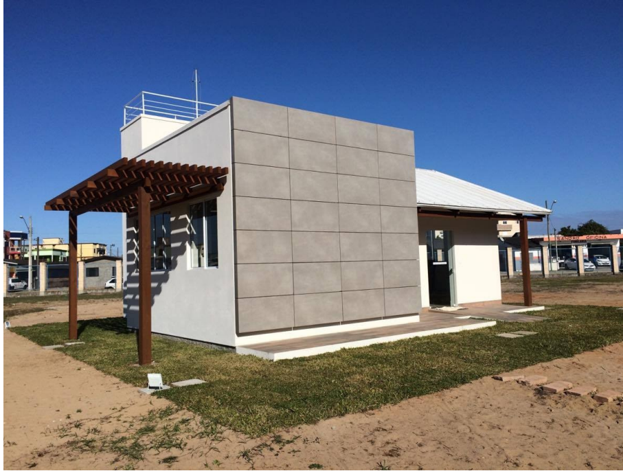
Figura 14 - Fachadas norte e leste da planta piloto (Fonte: Arquivo pessoal).
